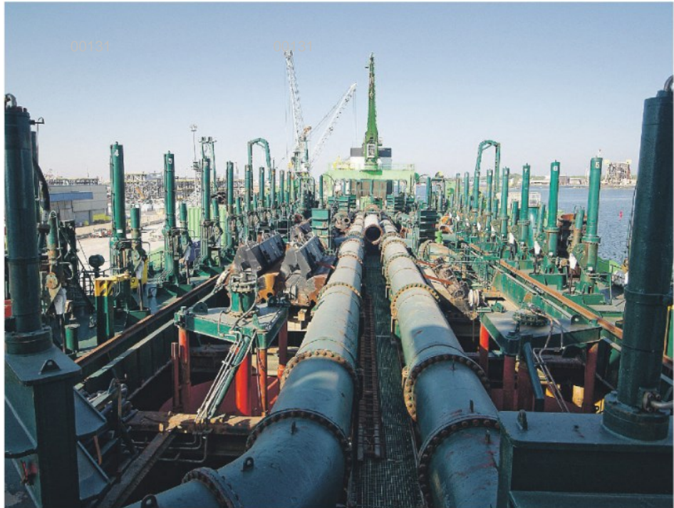
La draga impegnata nei lavori di scavo FOTO MASSIMO FLORENTINI
