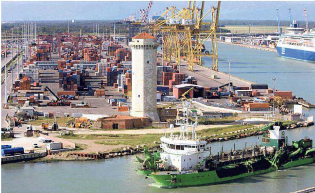
Porto: la draga per gli escavi e, alle spalle della Torre del Marzocco, il terminal container Tdt in Darsena Toscana
